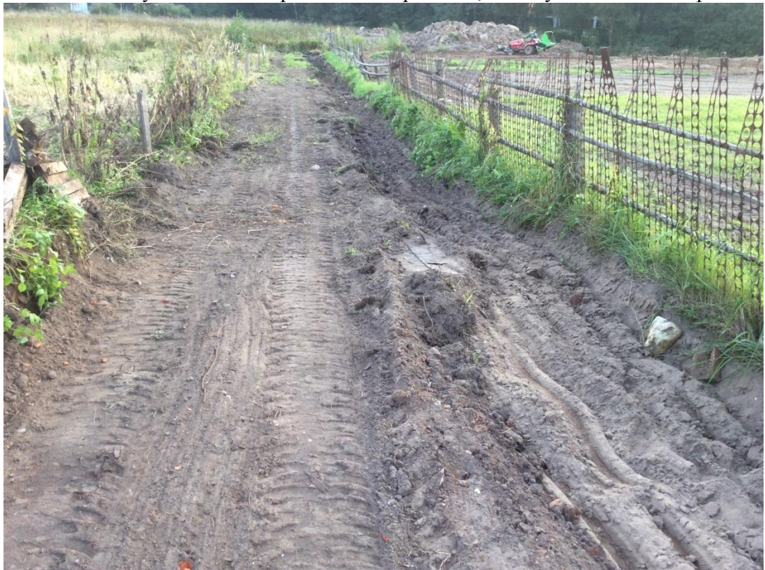
Рис. 12. Полоса снятого грунта, примыкающая к объекту «Межпоселковый и уличные газопроводы д. Горенское, г. Калуга». Вид с севера.
