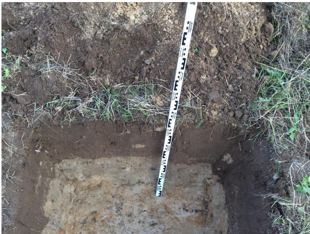
Рис. 39. Участок проведения археологических исследований на объекте «Межпоселковый и уличные газопроводы д. Горенское, г. Калуга». Шурф 4 Вид с востока.
